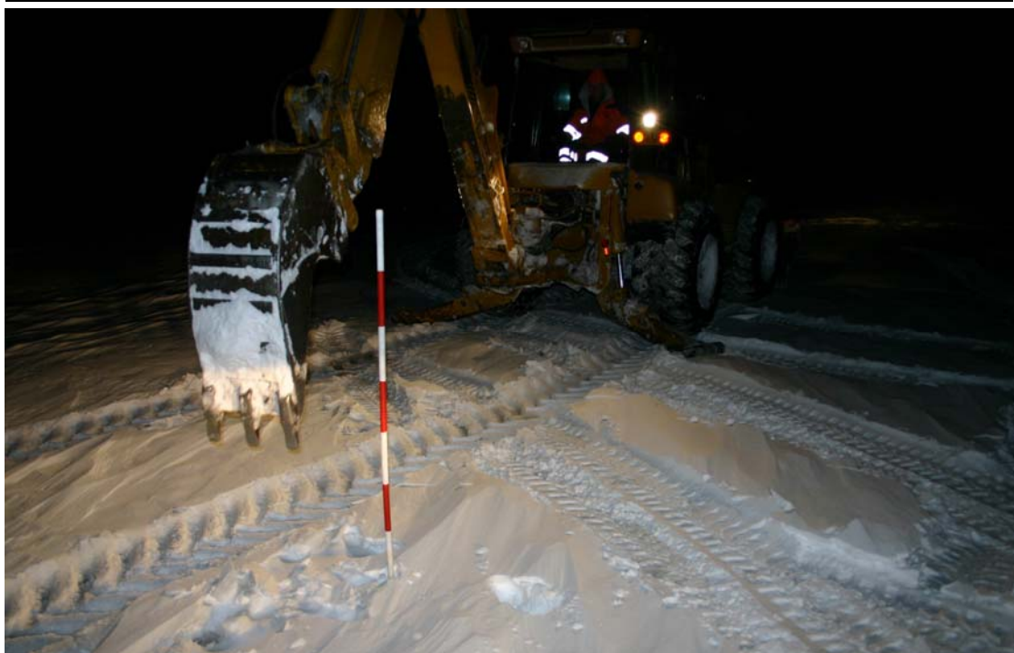
Mynd 3. Hydrema grafan gerir sig klára. (Landsvirkjun Victor Helgason, nóvember 2004)
