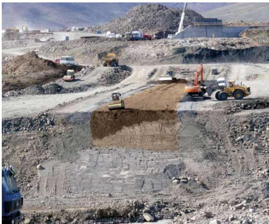
Unnið við Ufsarstíflu í október 2007.
