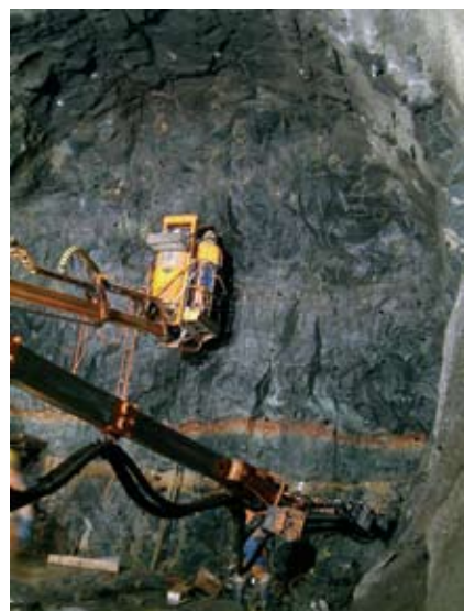
Sprenghleðslu komið fyrir í stafni frárennslisganganna í Fljótsdal við upphaf virkjunarframkvæmdanna.
