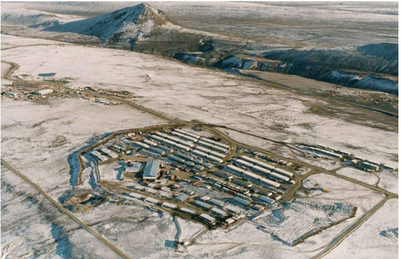
Laugarás, vinnubúðir Landsvirkjunar og Impregilo við Fremri-Kárahnjúk. Mynd: Emil Þór.
