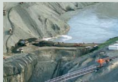
Horft yfir framkvæmdasvæðið við Fremri-Kárahnjúk í ágúst 2004.
