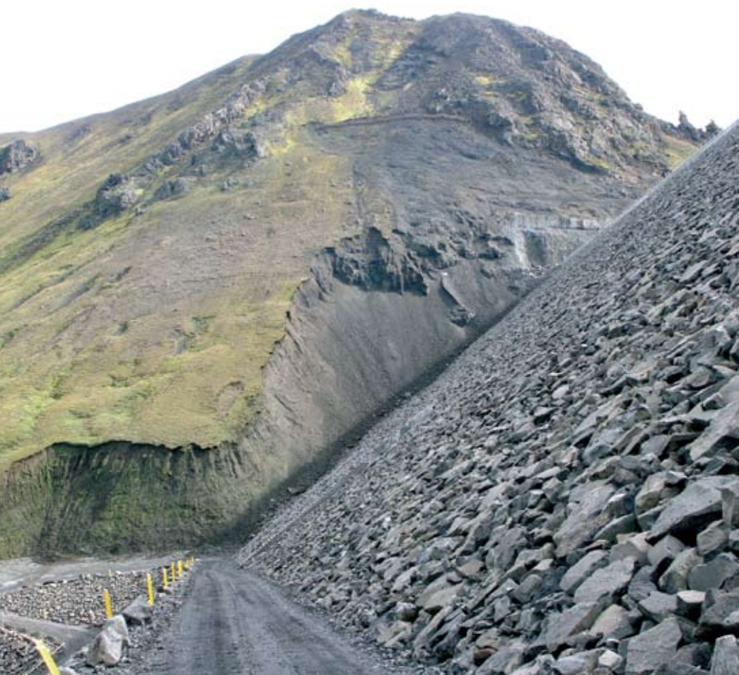
Greinilega sést framan við Kárahnjúka-stífluna þykktin á jarðveginum neðst í hjúknum þar sem sífrerinn var þegar Arnarfell hreinsaði af klöppinni 2003.
