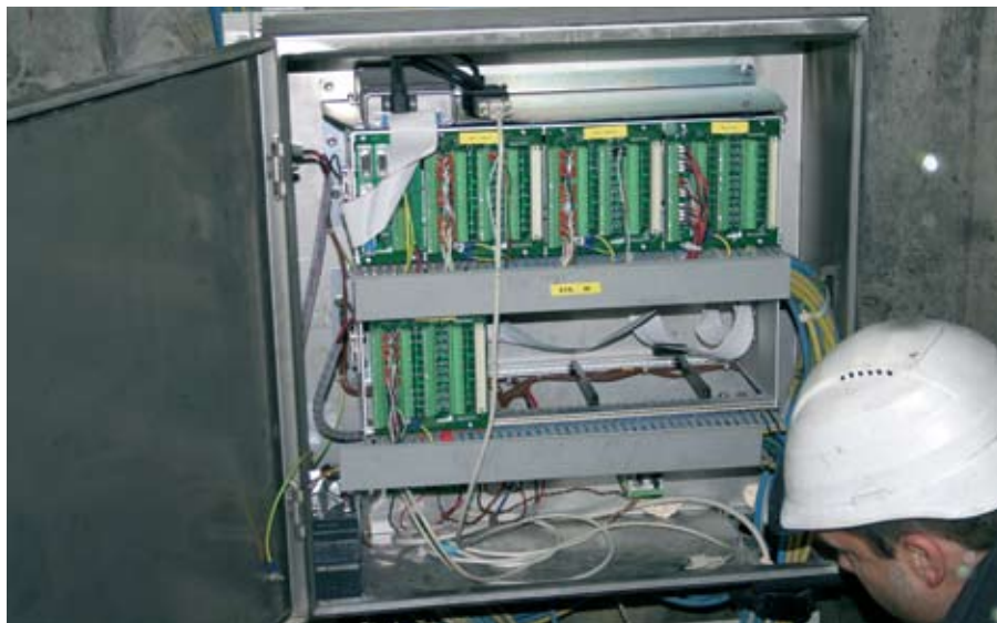
Ein fjölmargra stöðva sem safna upplýsingum um virkjunarmannvirkin og senda mælinganiðurstöður og aðvörun ef svo ber undir.
