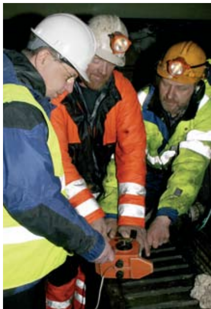
Agnar Olsen sprengir síðasta berghaftið í Kelduárgöngum Hraunaveitu austan Snæfells 9. apríl 2008.
