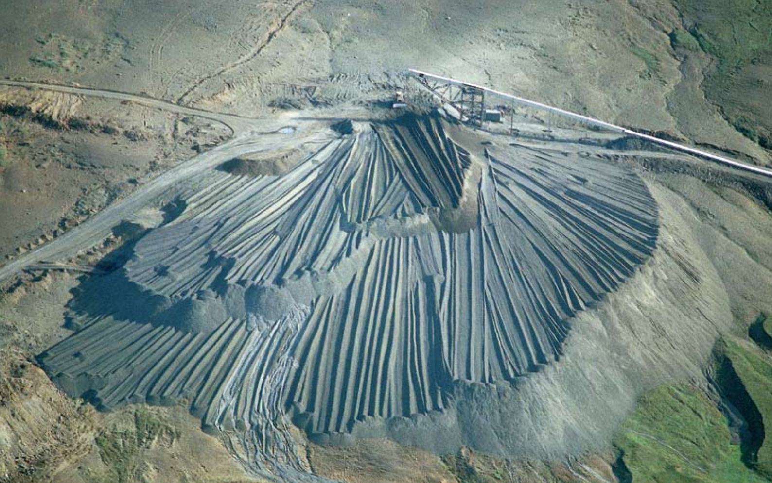
Haugur grjótmulnings frá einum af risaborunum þremur. Mulningurinn var fluttur á færriböndum frá borunum út úr aðrennslisgöngum virkjunarinnar og settur þar í hauga. Grjóthaugarnir voru síðan mótaðir þannig að líktist sem mest umhverfinu (sjá: Landið fært til fyrra horfs bls. 88). Mynd: Emil Þór.
