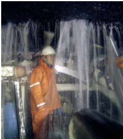
Jarðfræðingur framkvæmdaefirlitsins VIJUV „í sturtu“ í aðrennslisgöngunum í lok janúar 2005! Þetta var eitt mesta vatnsflóð inn í göngin sem um gat á framkvæmdatímanum. Mynd: Tom Olliver.
