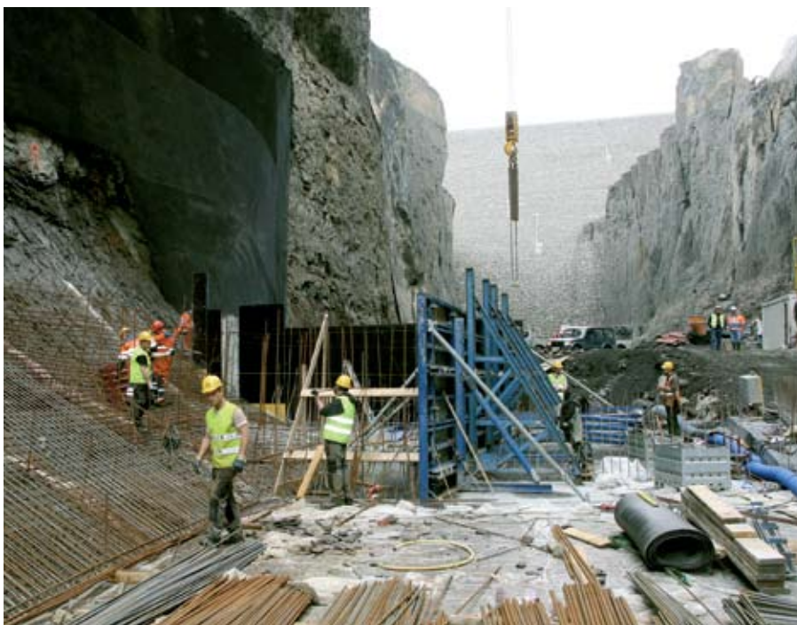
Unnið við stíflugerð í Hafrahvammaglúfri, neðan Kárahnjúkastíflu, í júní 2009. Þessi mannvirki varð að gera til að búa til lítið „lón“ eða hyl og eyða þannig orku úr fossinum Hverfanda.
