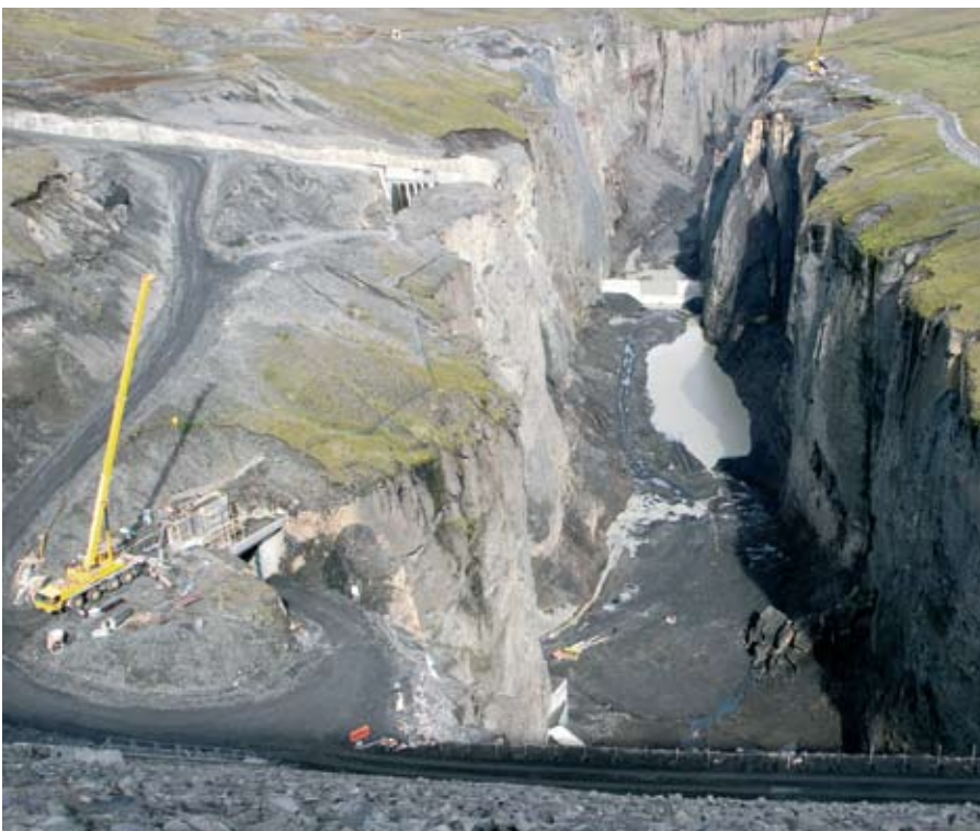
Horft af Kárahnjúkastíflu yfir gljúfrið og yfirfallið. Stíflan sem myndar „vatnspúðann“ undir yfirfallsfossinum Hverfanda sést fjær.
