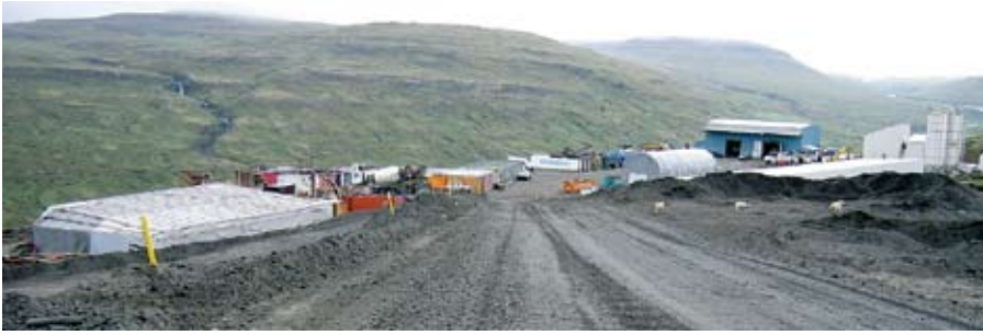
Fyrir hreinsun og landmótun við aðgöng 2.
