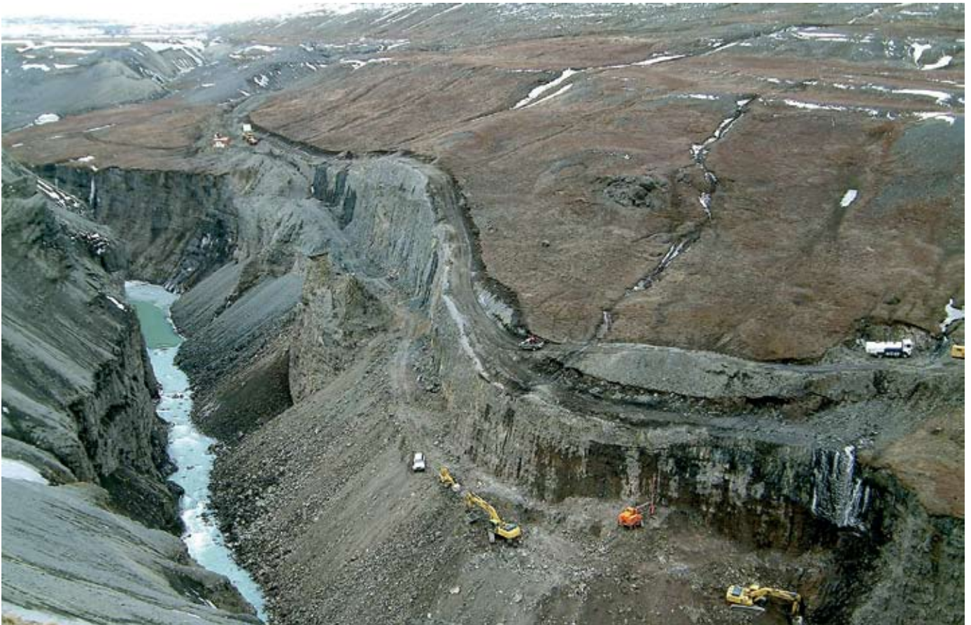
Við Hafrahvammagljúfur í apríl 2003 þegar framkvæmdir voru að hefjast af fullum krafti.
