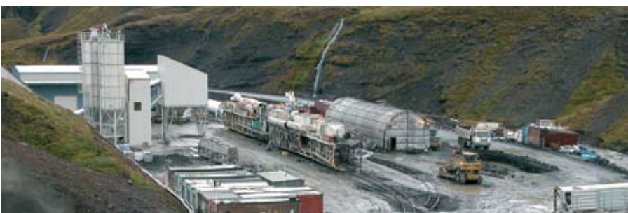
Fyrir hreinsun og landmótun við aðgöng 3.
