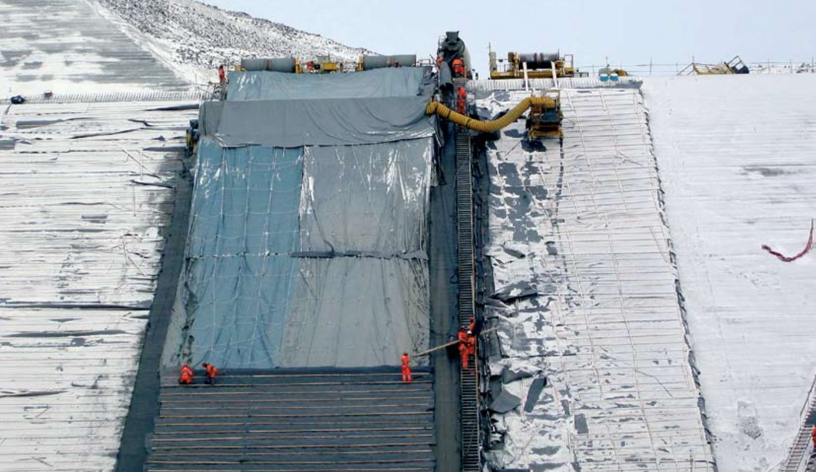
Steypt að vetrarlagi á Kárahnjúkastíflu 2005. Mynd: Sigurður St. Arnalds.
