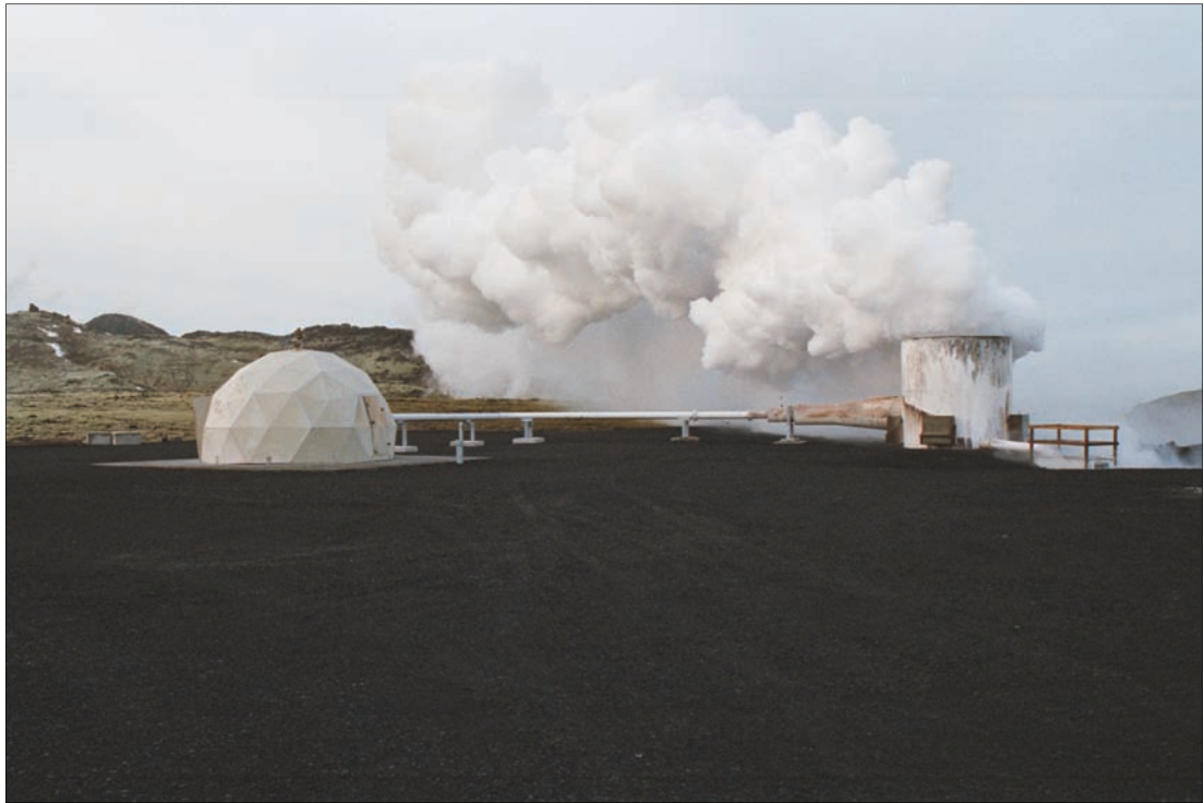
Mynd 4.5 Hefðbundinn frágangur borholu. Kúluhúsið er utan um sjálfa borholuna og gufan rýkur út um hljóðdeyfinn. Hægra megin við hann rennur affallsvatnið út.
