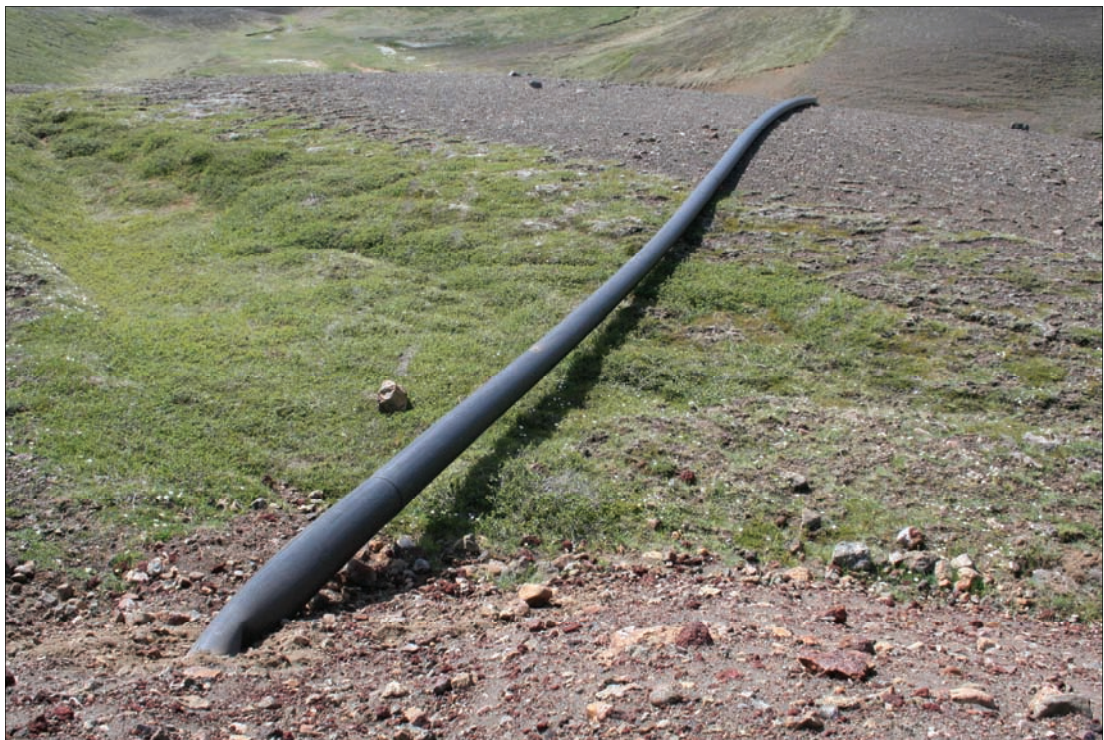
Mynd 4.6 Lögn sem flytur borvatn frá borun rannsóknaholu (úr svarfþró) og síðar skiljuvatn frá hljóðdeyfi við prófanir.
