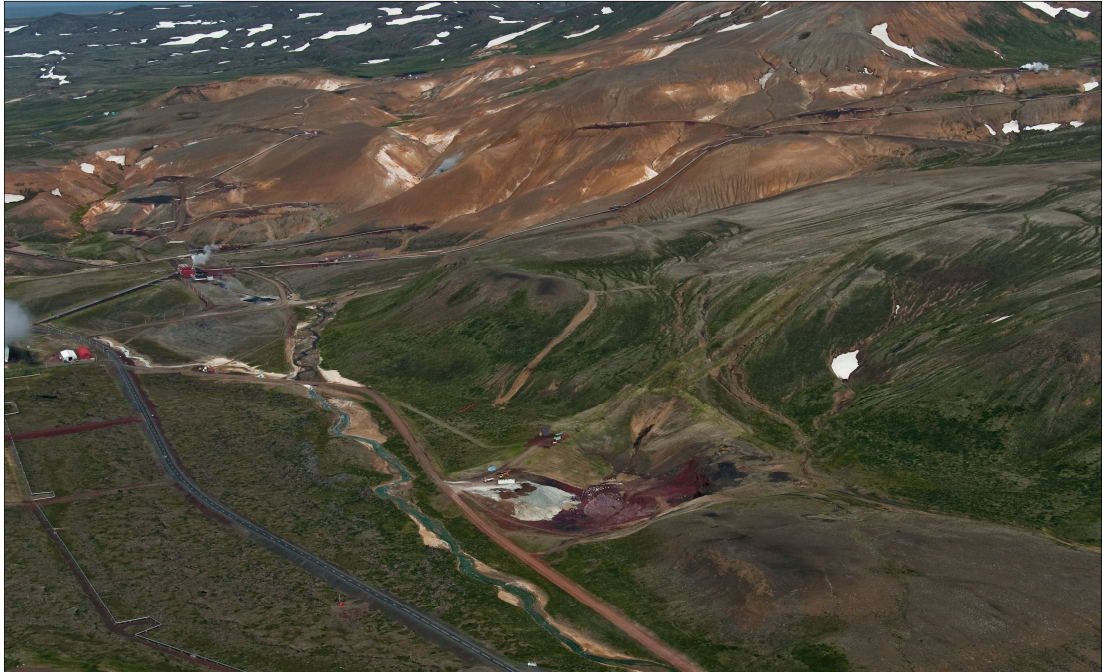
Mynd 4.6 Núverandi náma við Grænagilsöxl (ljósmynd Emil Þór, 2009). Fyrirhuguð stækkun námunnar er til suðurs (niður og til hægri á mynd), á milli hólsins og hlíðarinnar (sjá afmörkun námunnar á mynd 4.1).
