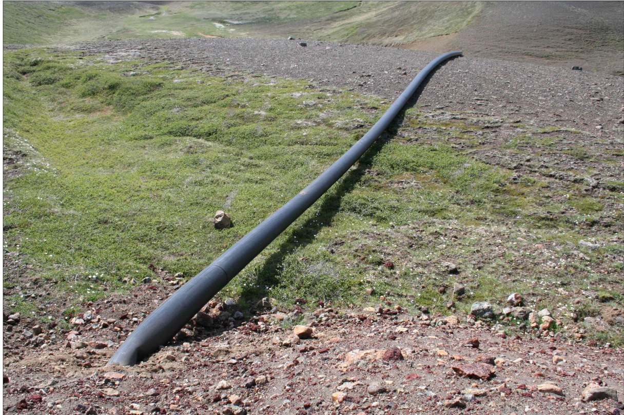
Mynd 4.5 Lögn sem flytur borvatn frá borun (úr svarfþró) og síðar skiljuvatn frá hljóðdeyfi við prófanir. Myndin er tekin af núverandi borteig við Rauðhól þar sem borsvæði H er fyrirhugað.
