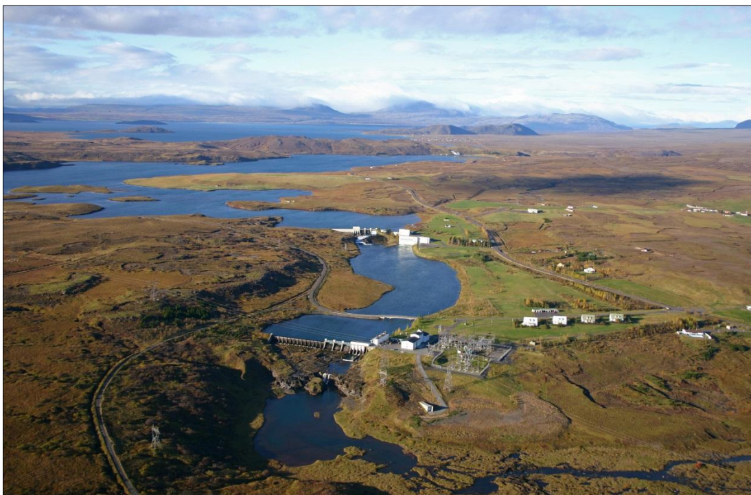
Mynd 1 Þingvallavatn, Úlfjótssvatn og hluta Sogsins. Steingrímsstöð við Dráttarhlíð, þá tekur við Úlfjótssvatn og Ljósafossstöð. Fremst á myndinni er Írafossstöð (Ljós. Jón H. Gíslason, dags. 6.10.2006).
