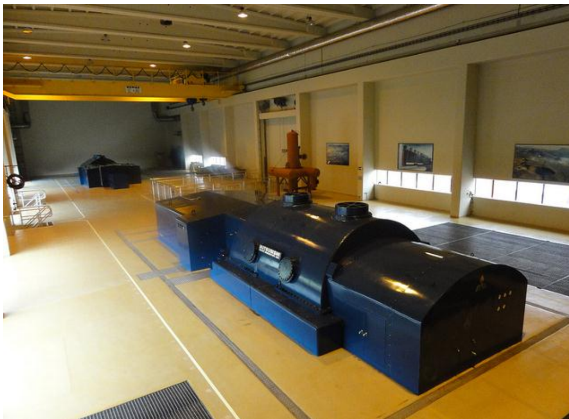
Mynd 14 – Á myndinni sjást báðir hverflar Kröfluvirkjunar. Hvor um sig framleiðir 30 MW e 42 .
