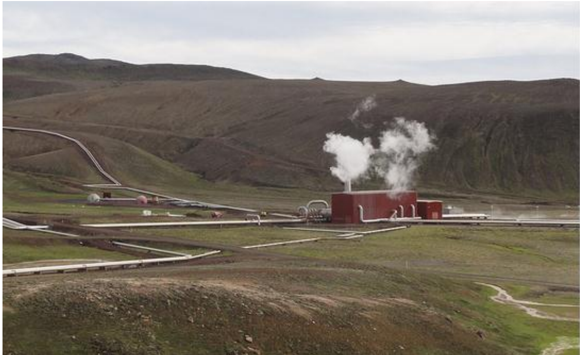
Mynd 13 – Á myndinni sést skiljustöð fyrir Kröfluvirkjun og stofnæðar 38 .
