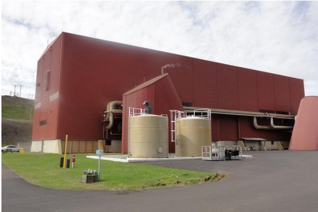
Mynd 15 – Stöðvarhús Kröfluvirkjunar 44 .
