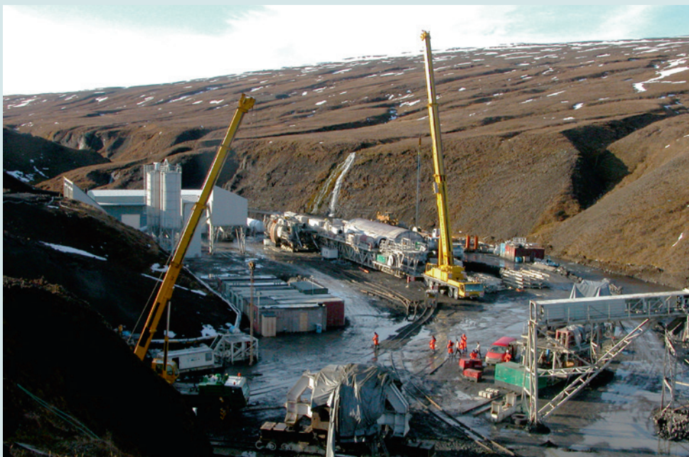
Mynd 20 — Athafnasvæði við gangamunna aðkomuganga númer þrjú meðan á framkvæmdum stóð (efri mynd) og sama svæði eftir frágang (neðri mynd).
