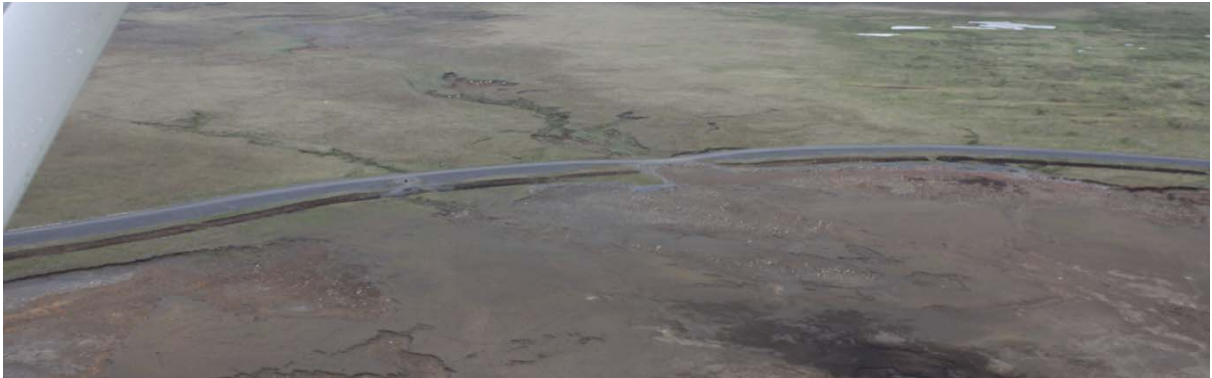
Mynd 5- 2; stöðvar 2400–2900, rofabarði milli 2410 og 2520 lokað 2012
