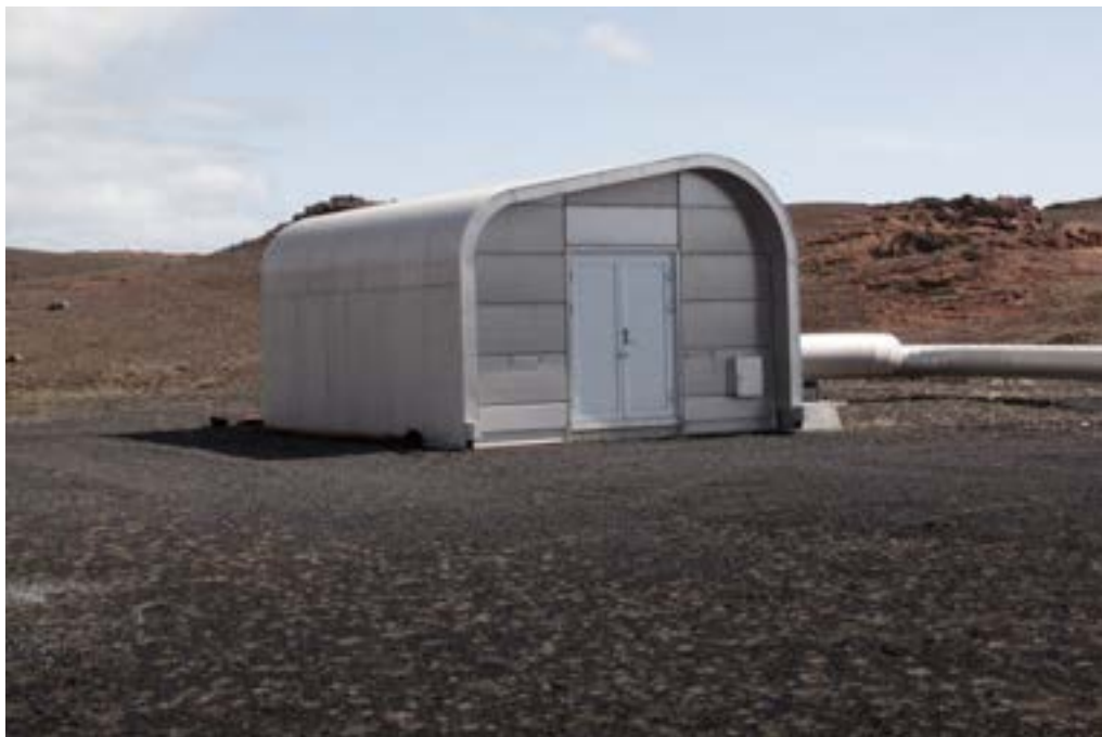
Borholuhús við Reykjanessvirkjun. UÓ 2013.
