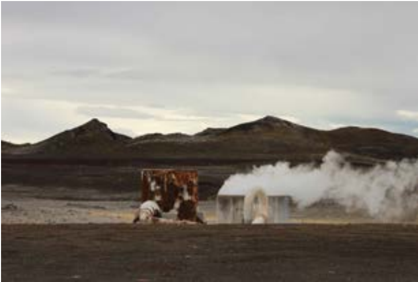
Færanlegur hljóðdeyfir ásamt steypum hljóðdeyfi í Bjarnarflagi.
