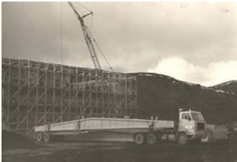
Bygging stöðvarhússins við Kröflu.
