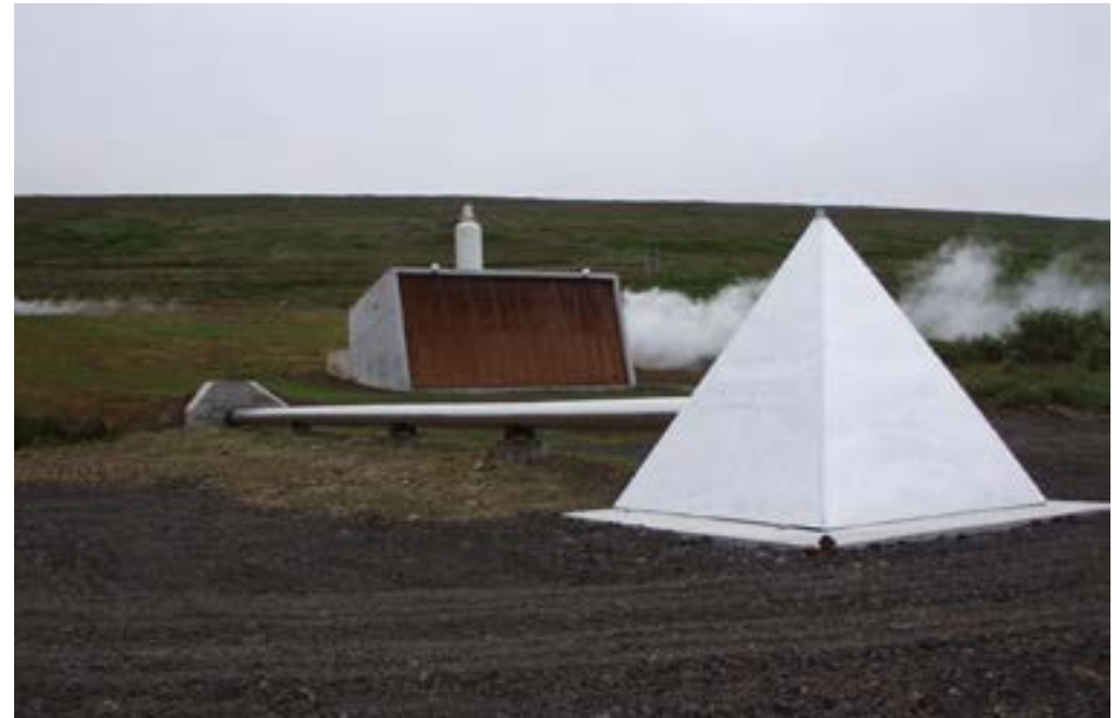
Smærri mannvirki við Orkuveitu Húsavíkur.
