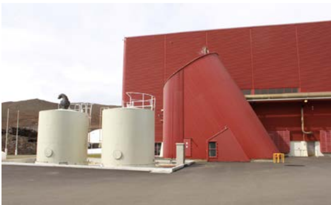
Stöðvarhús Kröflustöðvar. UÓ 2013.
