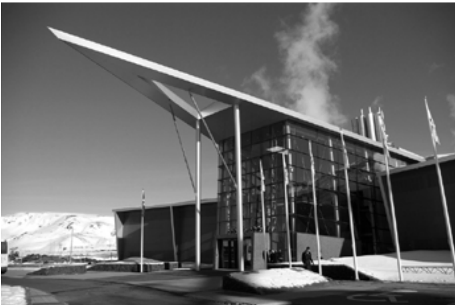
Mannvirki við Hellsheiðarvirkjun.
