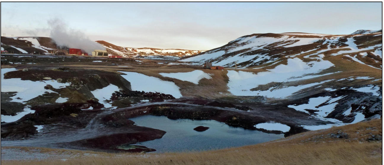
Mynd 7. Horft norður yfir námuna við Grænugilsöxl þann 21. nóvember 2014.
