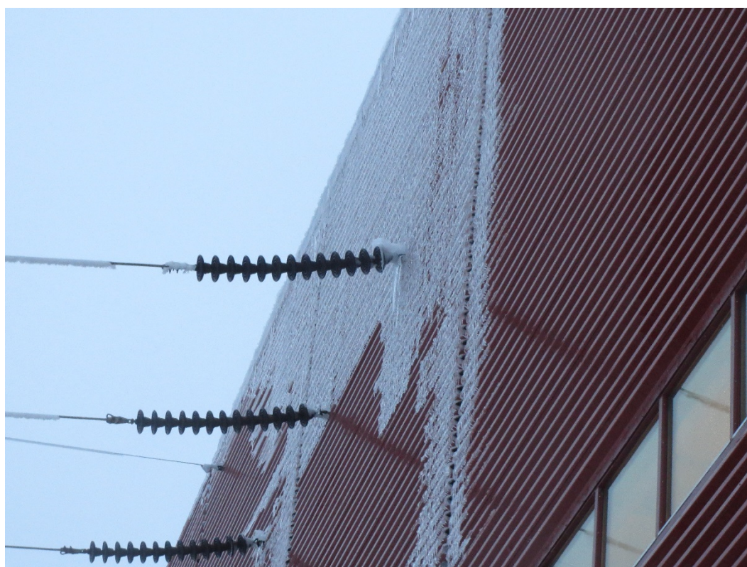
Ísing utan á stöðvarhúsi í Kröflu, hætta skapast þegar klaki fer að hrynja niður
