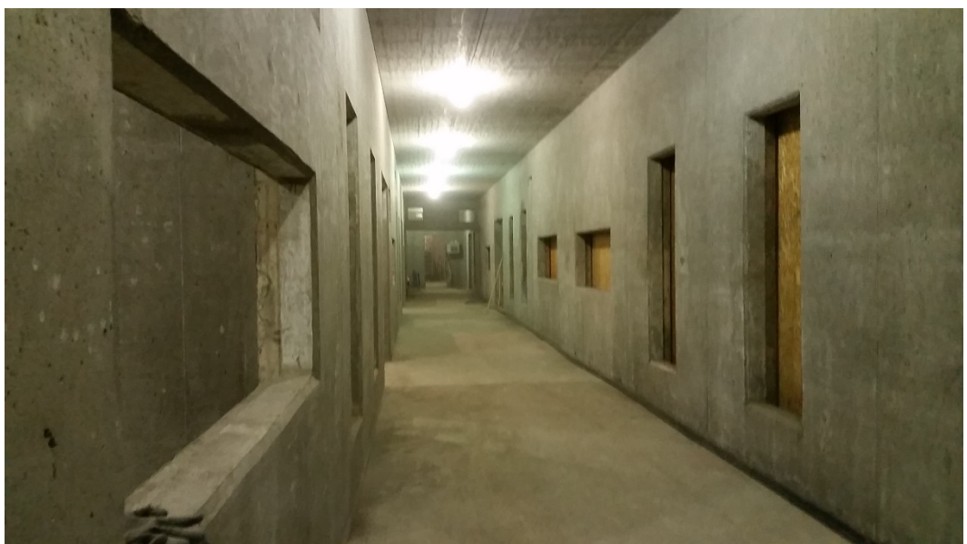
Þeistareykjavirkjun í byggingu, góð umgengni stuðlar að öruggu vinnusvæði
