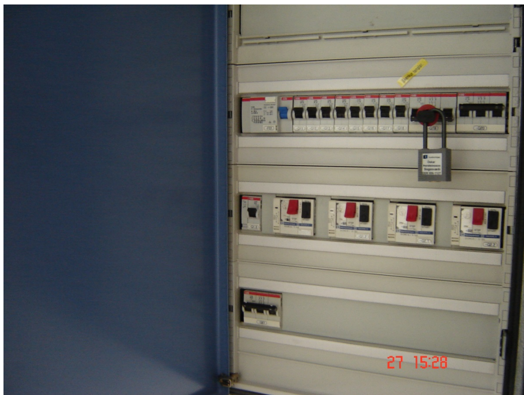
Mynd af Sogssvæði sem sýnir að persónulásar eru notaðir til að læsa rofum svo ekki er hægt fyrir slysi að ræsa vélar meðan unnið er í þeim
