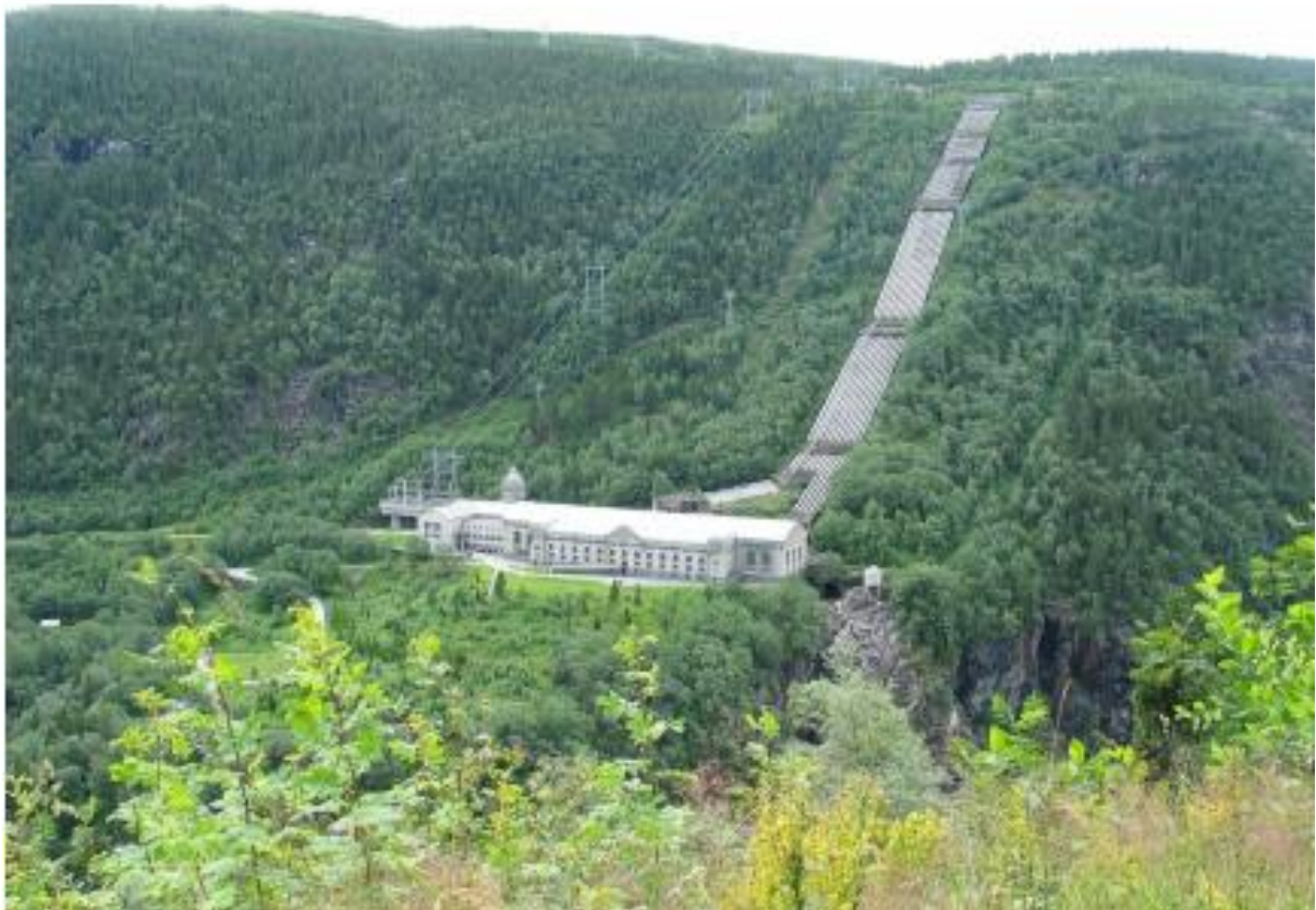
Mynd 12. Norska ríkisstjórnin tilnefndi árið 2014 mannvirki vatnsaflsvirkjunar Norsk Hydro í Rjukan og Notodden í Telemark frá 1934, til heimsminjaskrár UNESCO yfir sögulegar byggingar sem mikilvægt sögulegt mannvirki í iðnbýltingunni.
