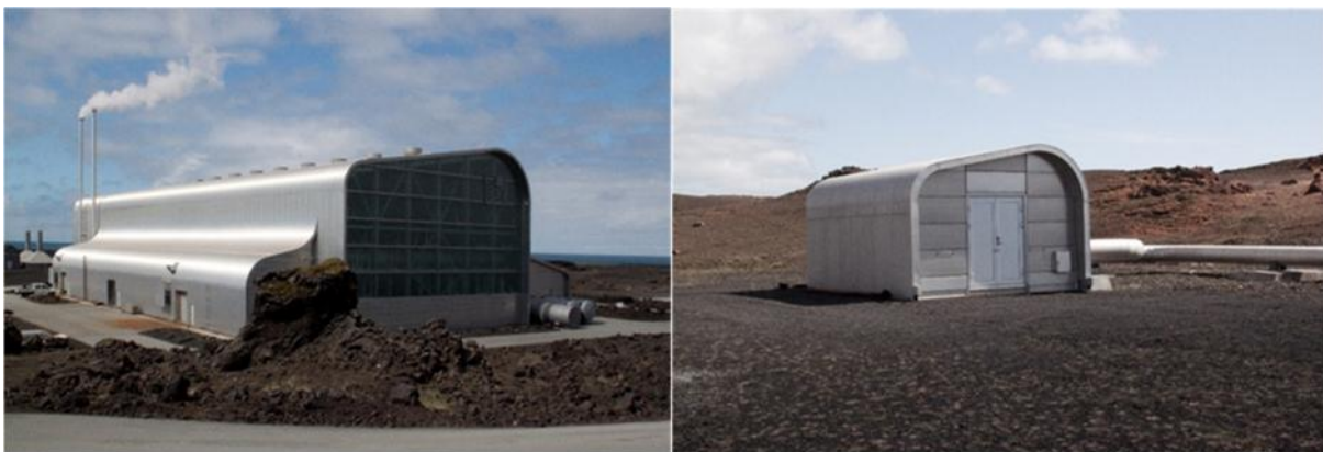
Mynd 11. Reykjanesvirkjun. Þakform, efnisnotkun og litir stöðvarhúss og borholuhúsa eru samræmd. Þakform tekur mið af Eldey sem er kennileiti á svæðinu. Hönnun OG arkitekta 2004.
