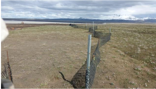
Mynd 4: Eldri girðing féll í bakka og var endursmíðuð í plasti og færð ofar. Talsverður sandburður uppá bakka. Ljós. RIH.
