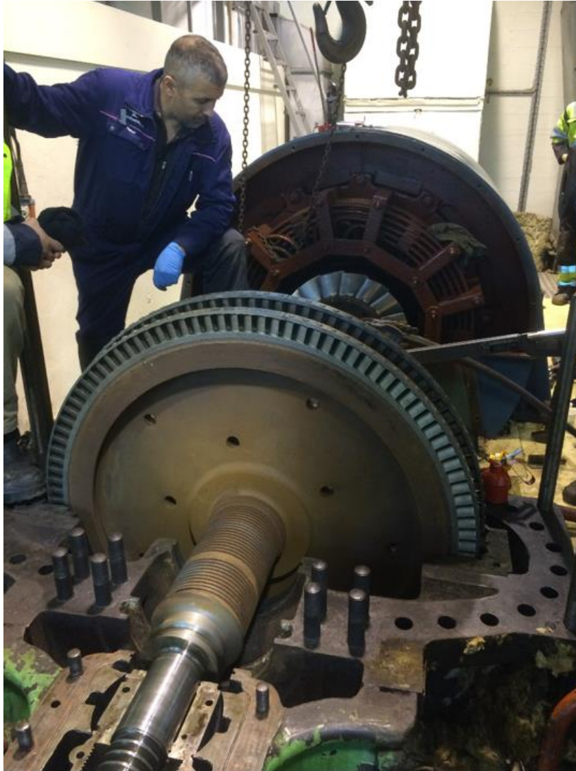
Mynd 6. Hverfilhjólíð sem sett var upp 2001. Mynd tekin í vélaupptekt í gufuaflsstöðinni. Mynd í eigu Landsvirkjunar.
