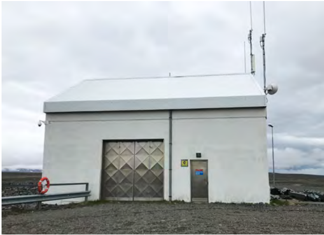
Inntakshús, horft úr suðri, 2020.
