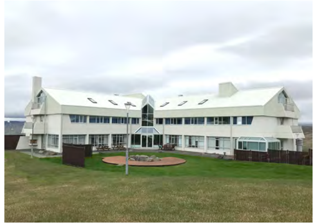
Starfsmannahús, horft úr suðvestri. Inngangsglerhvelfing fyrir miðju, 2020.
