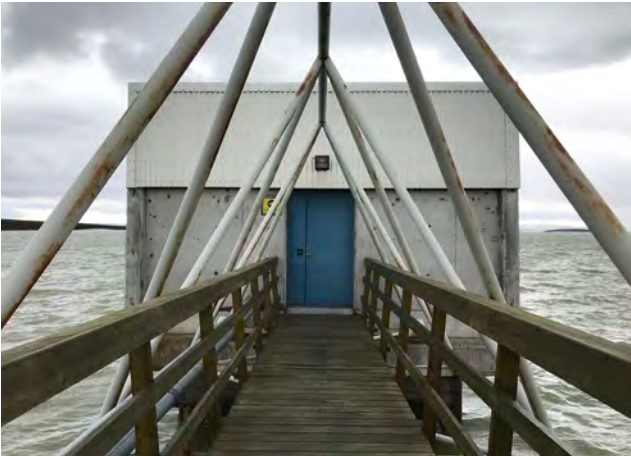
Horft yfir brú að hjálalokuhúsi, 2020.
