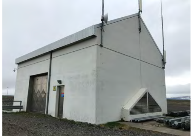
Inntakshús, horft úr suðaustri, 2020.
