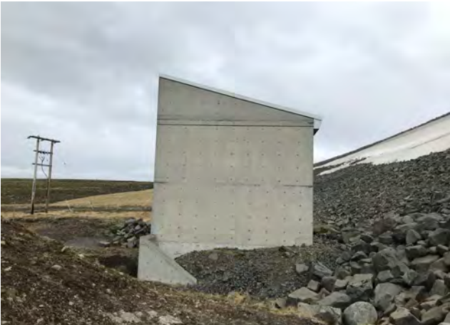
Lokuhús, horft úr vestri, 2020.
