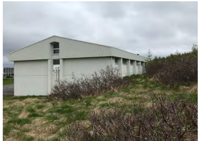
Verkstæðishús, horft úr suðaustri, 2020.
