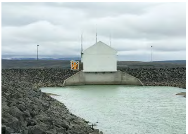
Inntakshús, horft úr vestri, 2020.
