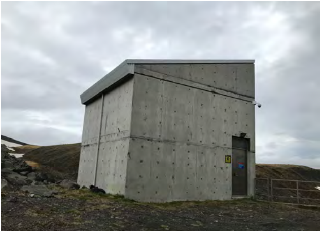
Lokuhús, horft úr norðaustri, 2020.
