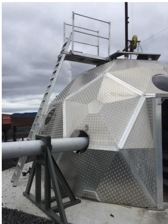
MYND 4 Holutoppur við eina borholu Þeistareykjastöðvar. Ljósmynd: ÍSOR [62].
