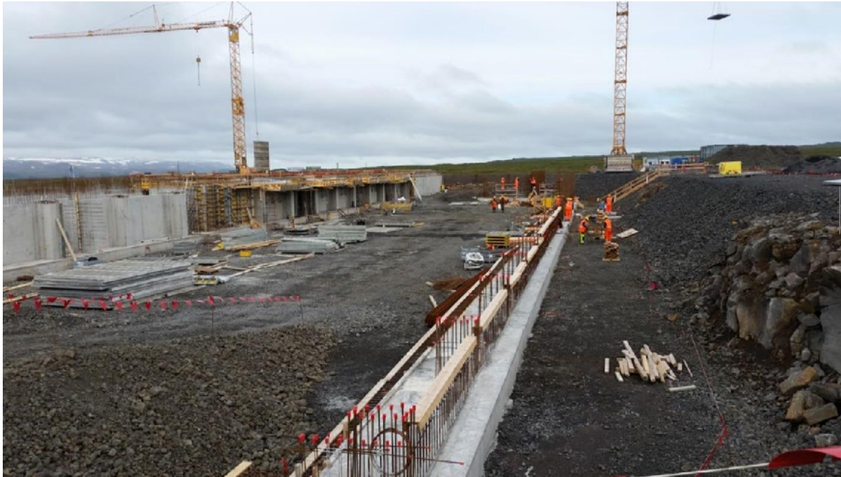
MYND 11 Bygging stöðvarhúss Þeistareykjastöðvar. Ljósmynd: Landsvirkjun.
