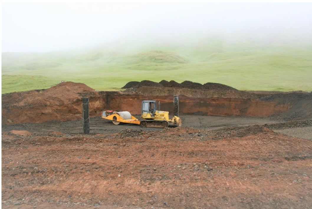
Stækkun borsvæðis B-A fyrir borholur ÞG-04 og ÞG-05 - Mynd tekin 28. júní 2007
