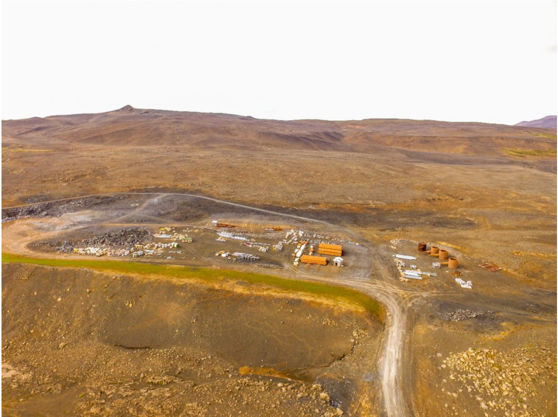
Náma RHN-10 (Jónsnípunáma), svæðið notað sem lagersvæði fyrir Landsnet og gufuveitu. Náman er einnig nýtt sem tippur fyrir ýmis jarðvegsefni frá virkjunarframkvæmdum og línulögn - Mynd tekin 31. ágúst 2017
