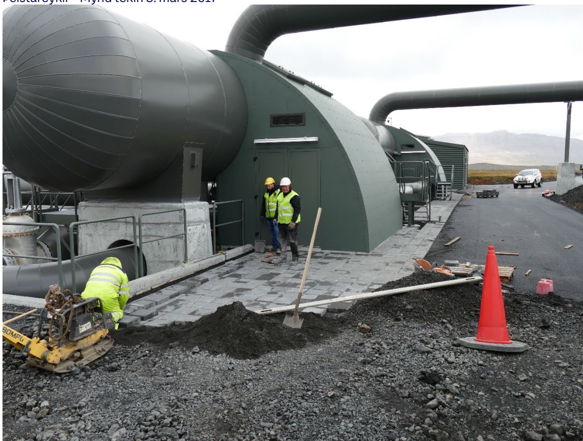
Yfirborðsfrágangur við skiljustöð - Mynd tekin 29. ágúst 2018
