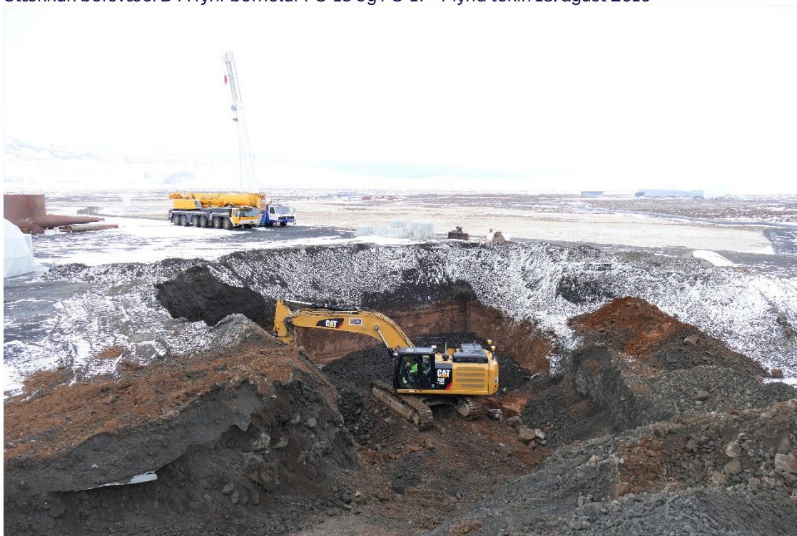
Jarðvinna fyrir undirstöður gufulagna á borsvæði B-B - Mynd tekin 21. apríl 2017
