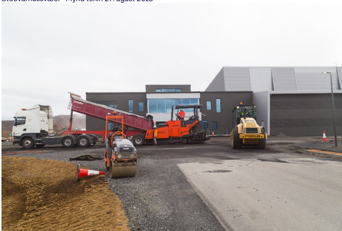
Frágangur við stöðvarhús - Mynd tekin 8. september 2018
