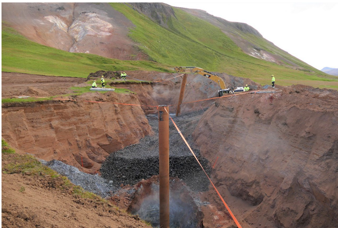
Stækkun borsvæði B-A fyrir borholur ÞG-13 og ÞG-17 - Mynd tekin 18. ágúst 2016
