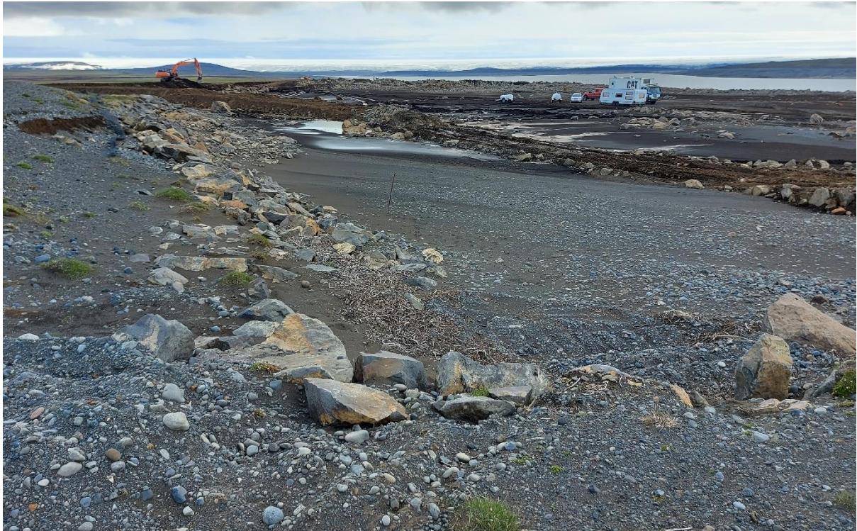
Mynd 8. Unnið að lagfæringum og uppsetningu á nýjum foggildrum syðst á Kofaöldu.
