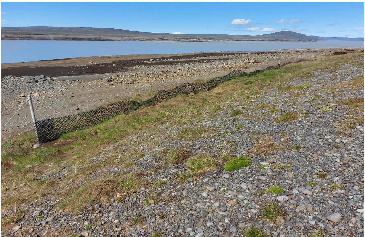
Mynd 9. Foggirðingar lónmegin við veginn á Kofaöldu þar sem sjá má lítilsháttar áfok sem hefur þó ekki borist yfir veginn.
