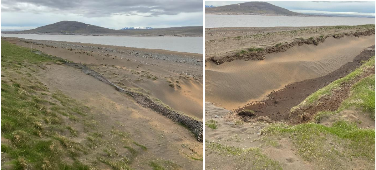
Myndir 1 og 2 – Sandur hefur safnast saman við fokgirðingar og ofan í sandgildirur sem staðsettar eru neðan Hálsvegs, 11.7.2022
