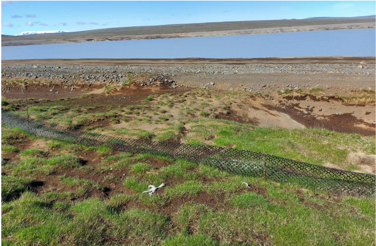
Mynd 4. Fokgirðing milli skurða vestan vegarins á Lindabungu. Lítilsháttar ummerki um ný áfoksefni en ekki mikið efni í skurðum.
