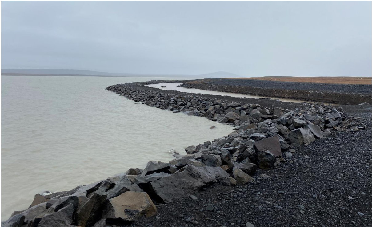
Mynd 2. Varnargarðar Landsvirkjunar í Lónsborðinu verja ströndina fyrir frekara rofi vegna öldu og grípa áfoksefni þegar vatnsstaða í lóninu er lág.
