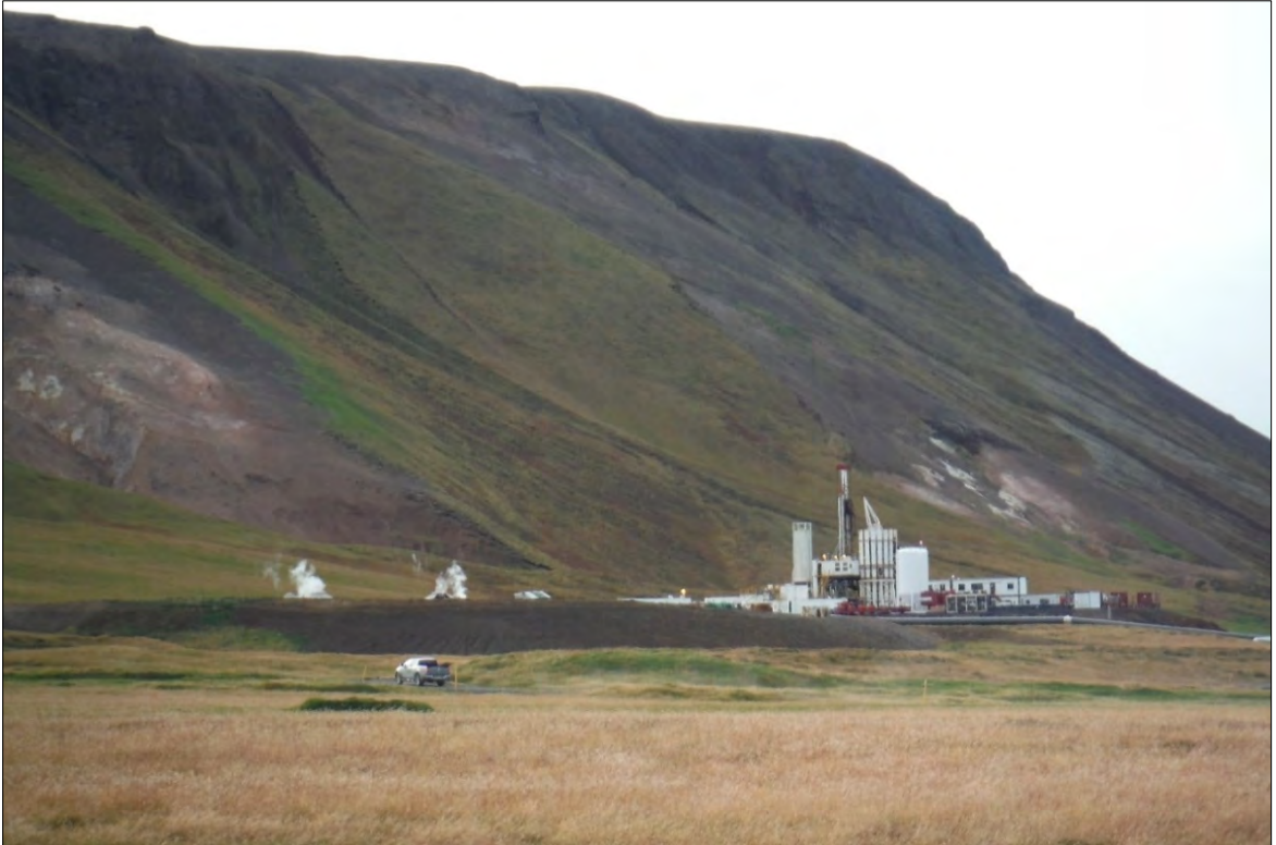
Mynd 8: Jarðborinn Óðinn við borun holu ÞG-13 á teig A á Þeistareykjum.
