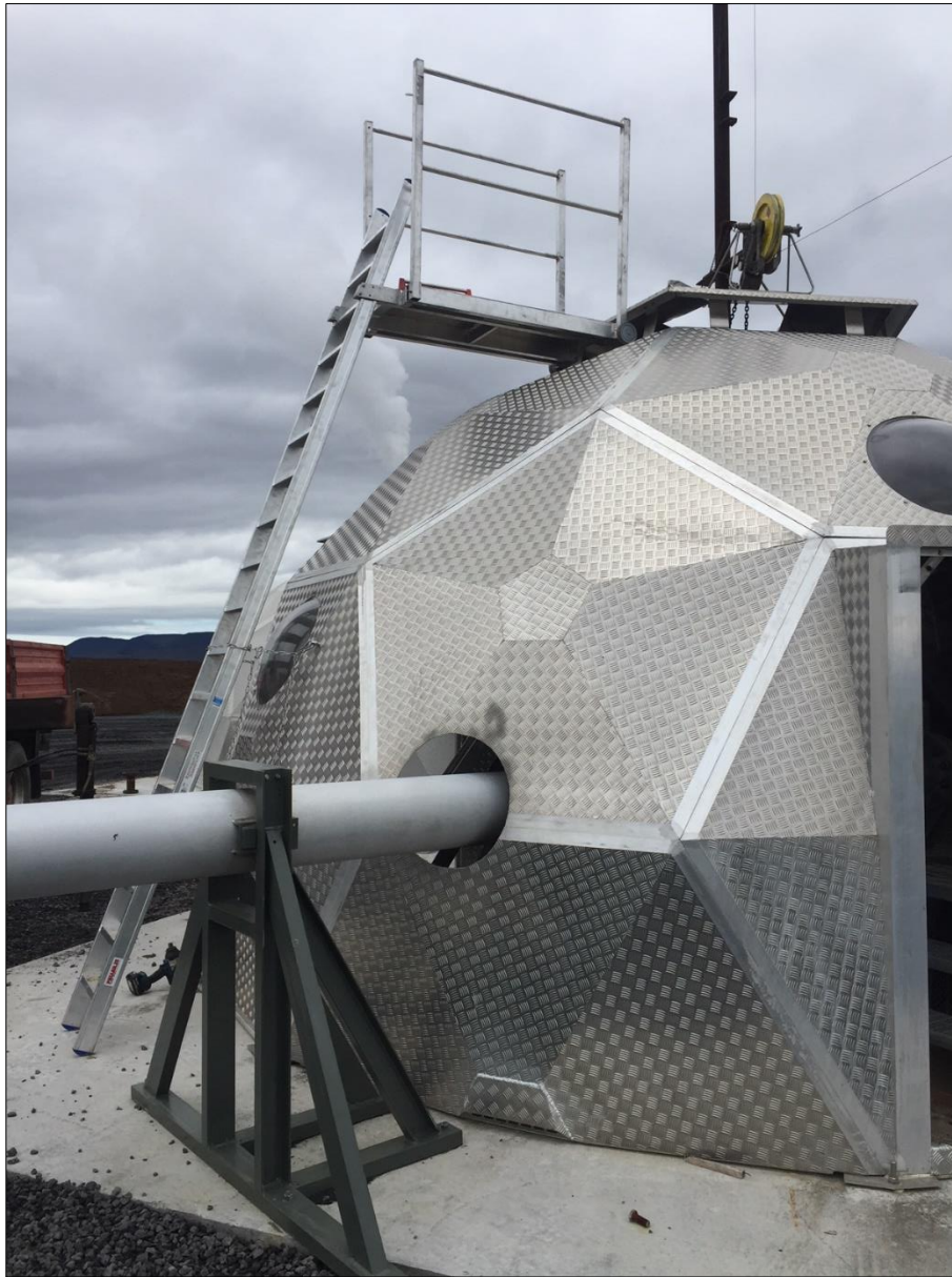
Mynd 6. Nýtt aðgengi að holutoppi var kynnt fyrir mælingamönnum ÍSOR í mæliferðinni 16.–18. júlí. Lipur og færarlegur stigi með vinnupalli (ljósmynd: HÖS).
