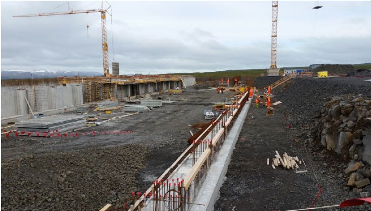
MYND 11 Bygging stöðvarhúss Þeistareykjastöðvar. Ljósmynd: Landsvirkjun.
