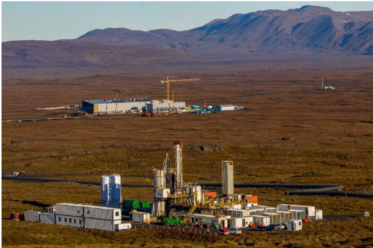
MYND 5 Framkvæmdir við stöðvarhúsið haustið 2016, borhola ÞG-12 í forgrunni. Ljósmynd: Landsvirkjun [18].
