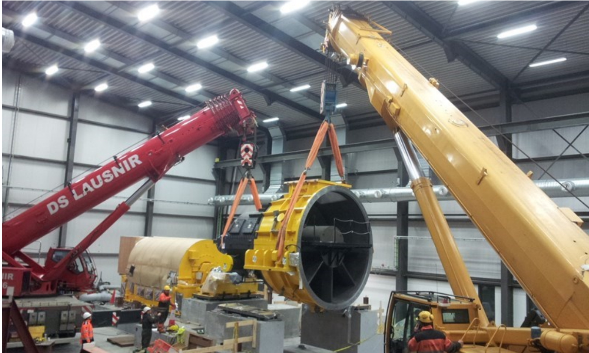
MYND 7 Hverfill fyrstu vélasamstæðu færður á sinn stað á Þeistareykjum með aðstoð tveggja krana í febrúar 2017. Ljósmynd: Landsvirkjun.
