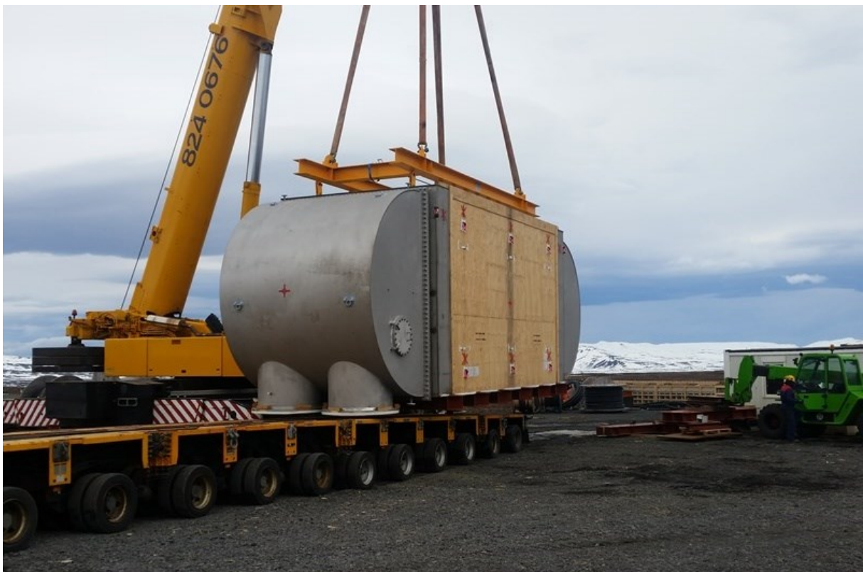
MYND 8 Eimsvali vélasamstæðu tvö frá Balcke-Dürr hífður á geymslusvæði utan við stöðvarhús Þeistareykjavirkjunar. Ljósmynd: Landsvirkjun.
