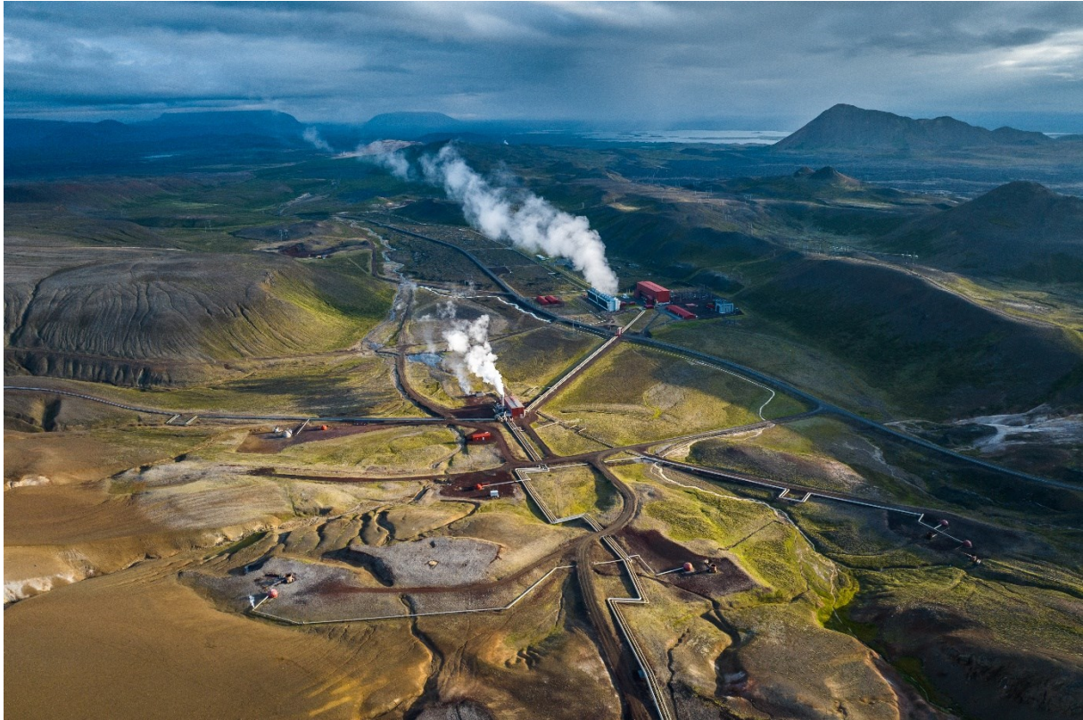
MYND 5 Aðkoma að Kröflustöð er eftir Kröfluvegi nr. 863 frá Þjóðvegi 1 sem er um 9 km langur.
