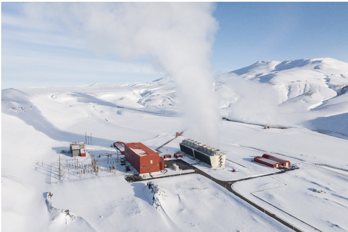
MYND 8 Loftmynd af Kröflustöð frá 2024 sem sýnir helstu mannvirki stöðvarinnar. Mynd: Landsvirkjun.
