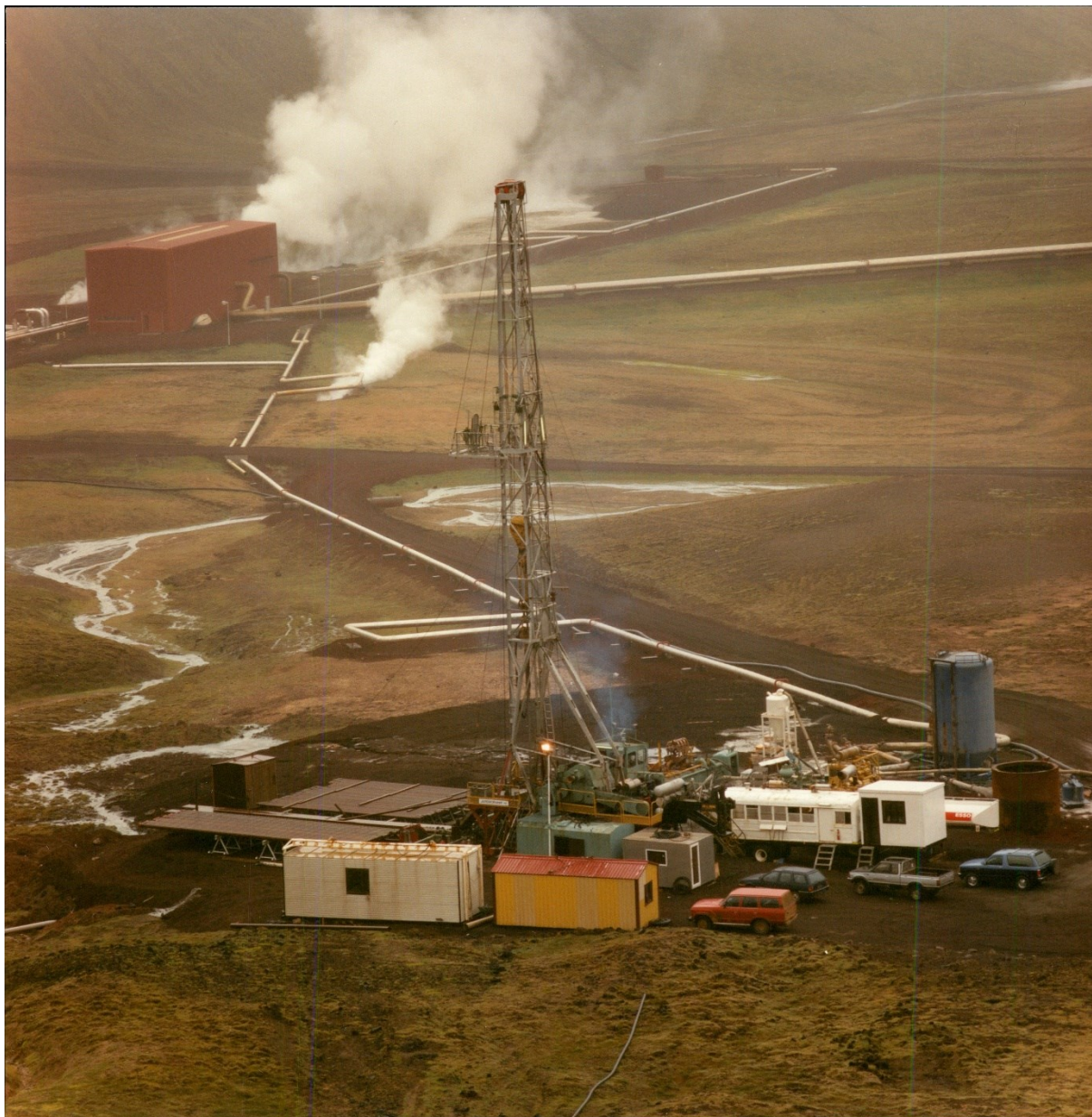
MYND 6 Unnið við borun og fóðrun á einum af borholum Kröflustöðvar árið 1988. Mynd: Landsvirkjun.
