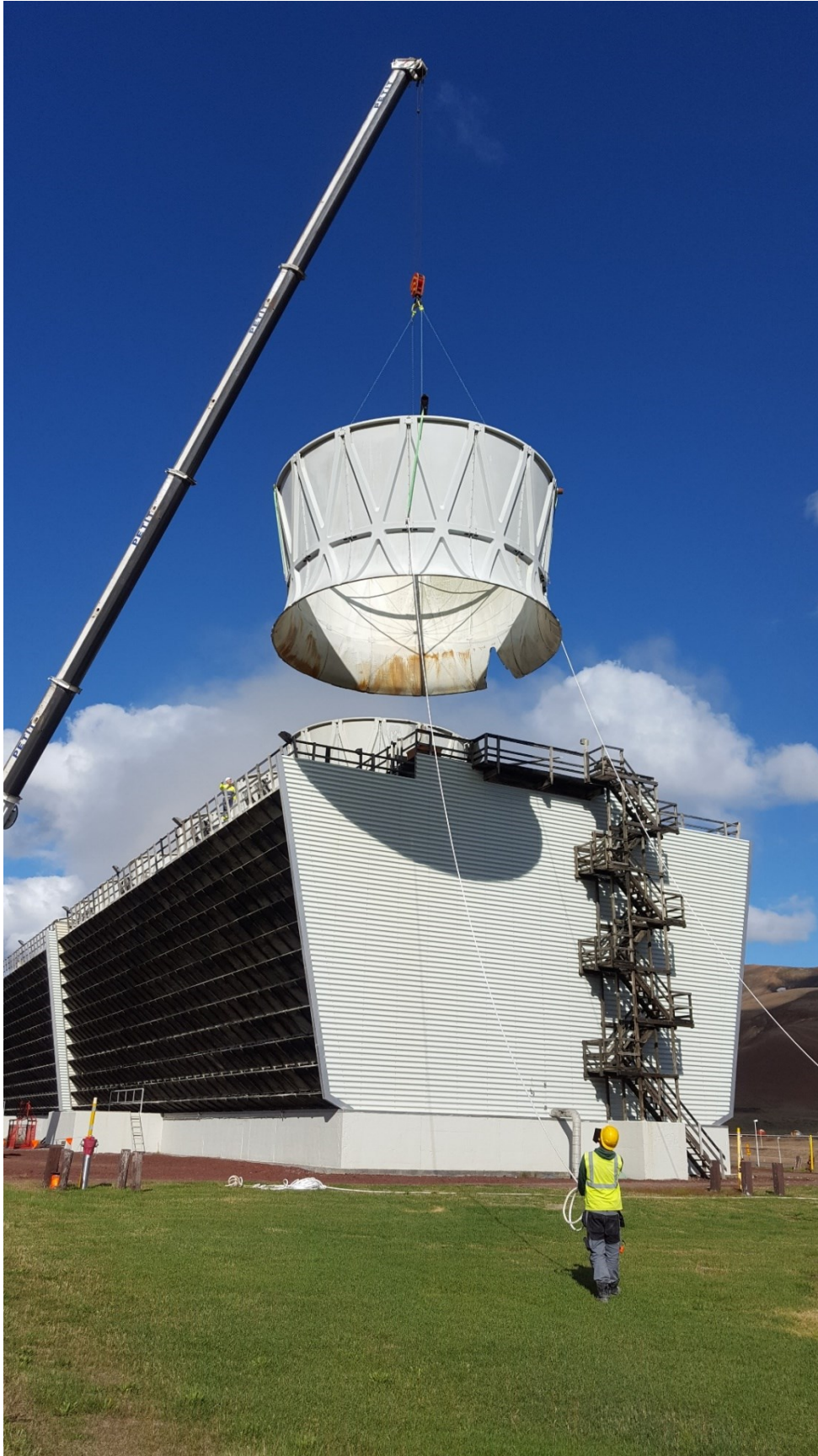
MYND 13 Unnið að endurnýjun á kæliturni 1 í Kröflustöð. Mynd: Landsvirkjun.
