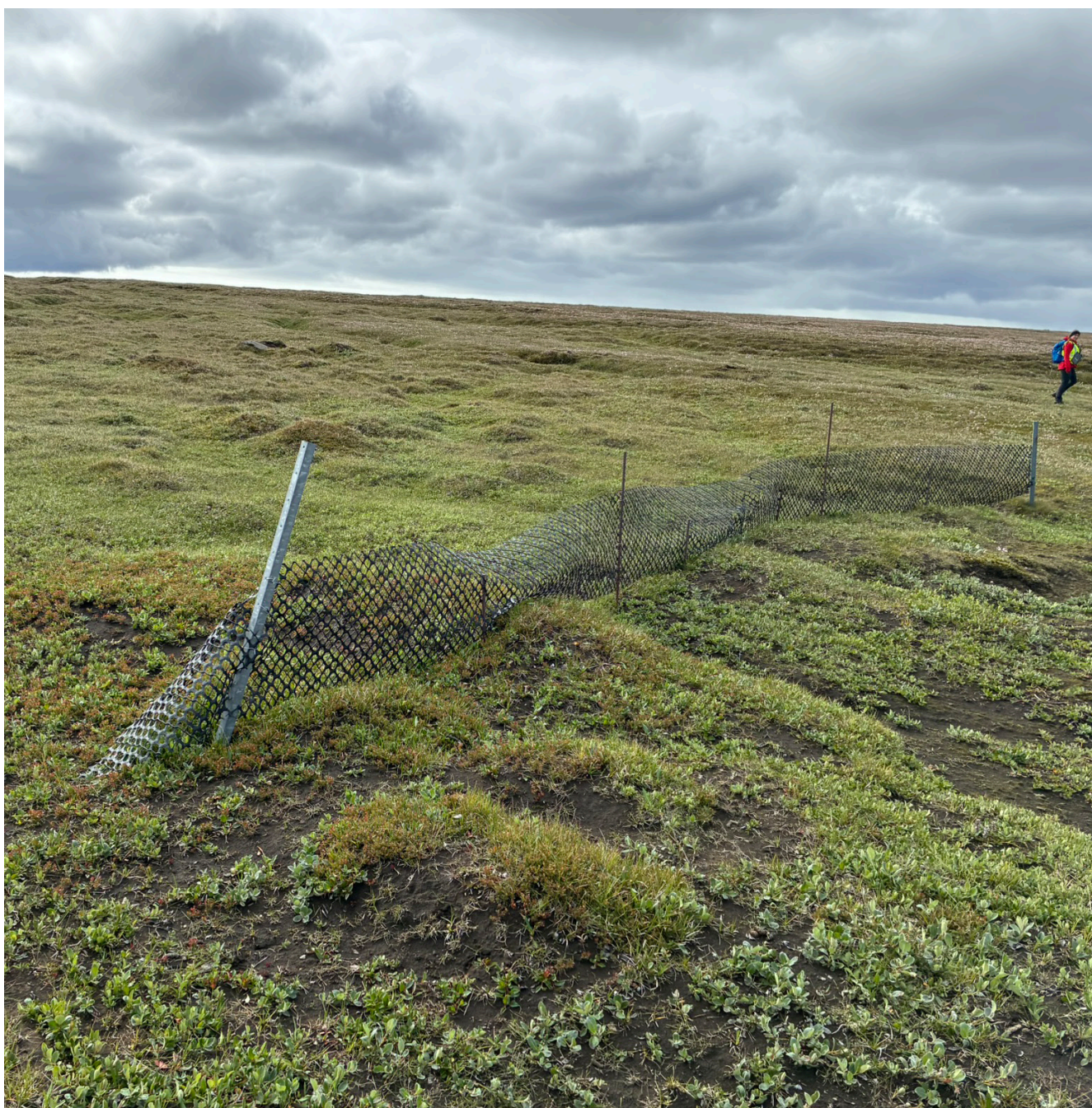
Mynd 2. Eitthvað þurfti að strekkja á og laga til girðingar sem höfðu eðlilega eitthvað slaknað í vetur, en stóðu þó. Þessi girðing er í Kringilsárrana og ljóst að hún sinnir sínu hlutverki, sé hún í lagi. Strekkt var á henni og endinn reistur við.
