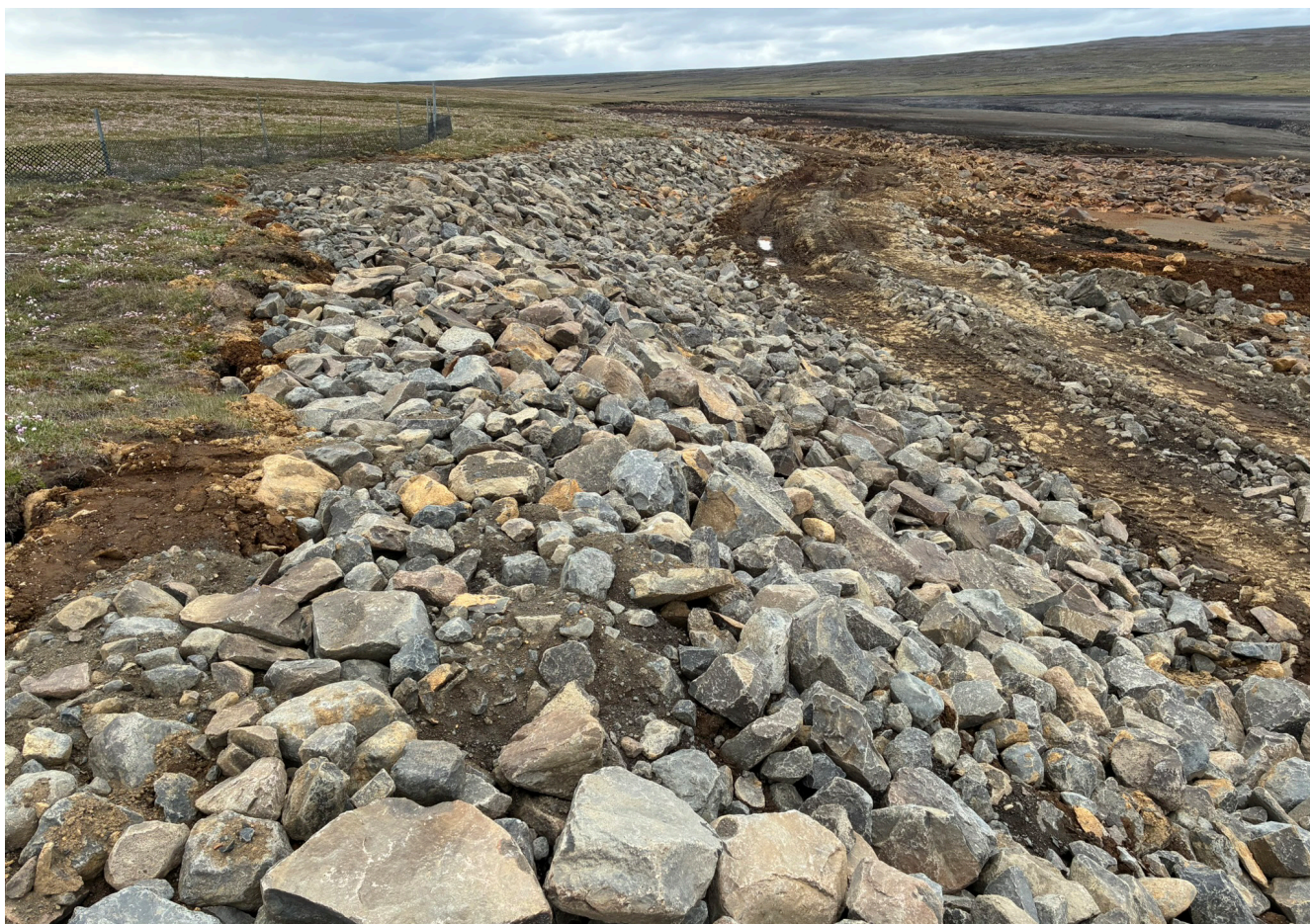
Mynd 15. Nýr varnargarður á norðurströnd Kringilsárrana sem kemur í framhaldi af eldri varnargarði Kringilsármegin. Vonir eru bundnar við að varnargarðurinn muni, auk þess að stöðva landbrot, grípa áfoksefni á leið sinni inn í ranann.
